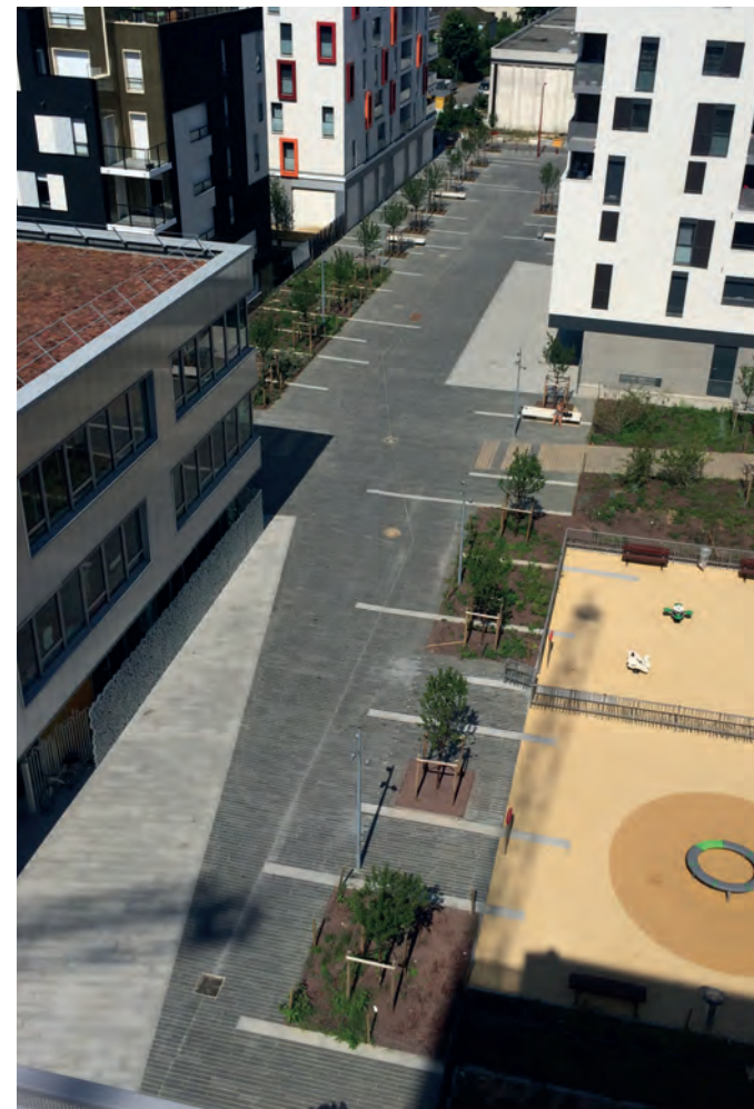
Un traitement unitaire des espaces publics de la ZAC associant le coeur du nouveau quartier avec l'Avenue de la Cerisaie
